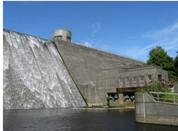
Llysfron Dam, Pembrokeshire
